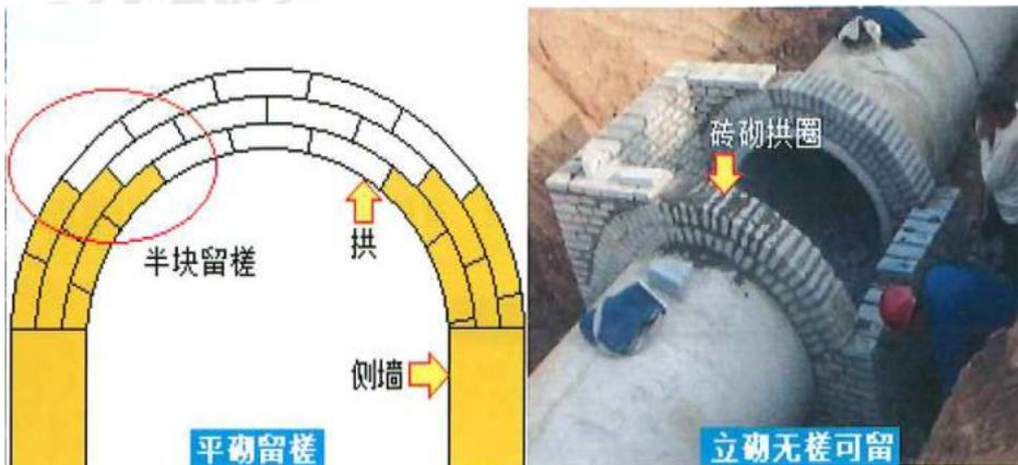
C 错误。圆井砌筑砌块砌筑时, 铺浆应饱满, 灰浆与砌块四周粘结紧密、不得漏浆, 上下砌块应错缝砌筑。砌筑时应同时安装踏步, 踏步安装后在砌筑砂浆未达到规定抗压强度等级前不得踩踏。
